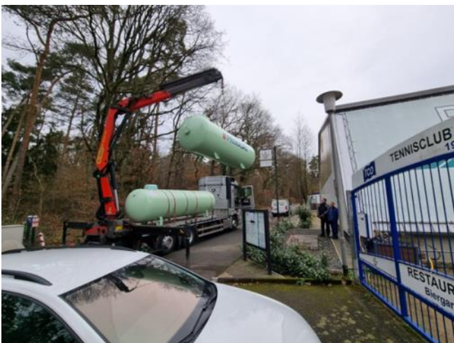
Der Tank „schwebt“ zu seinem Platz vor der Halle
